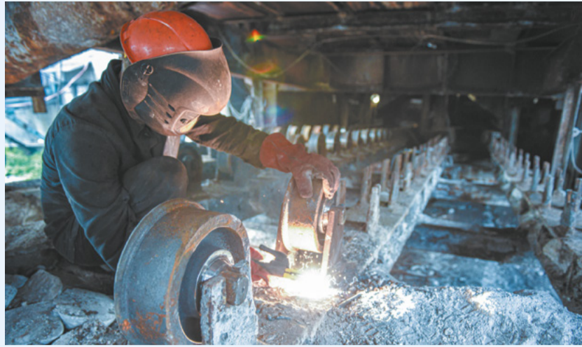
Часть оборудования была отремонтирована на месте.
