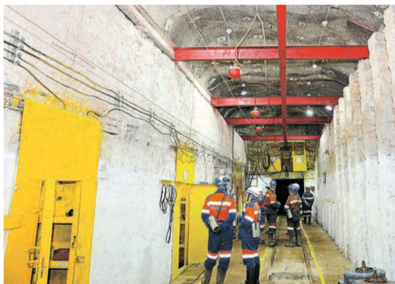
Комиссионный осмотр электровозного депо шахты горизонт – 71 метр.
