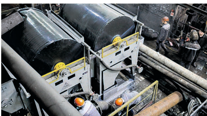
Монтаж новых магнитных сепараторов.
