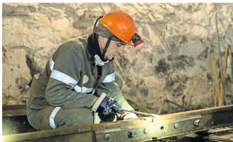
Закрепление стыковых болтов.
