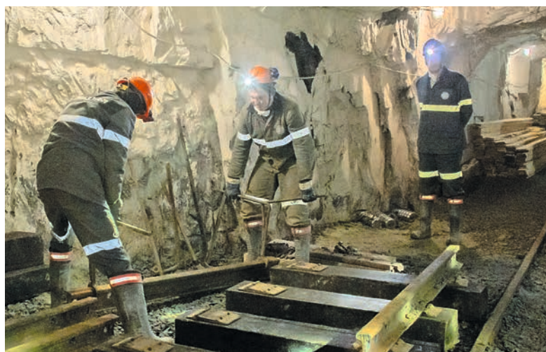
Укладка рельса на шпалы.
