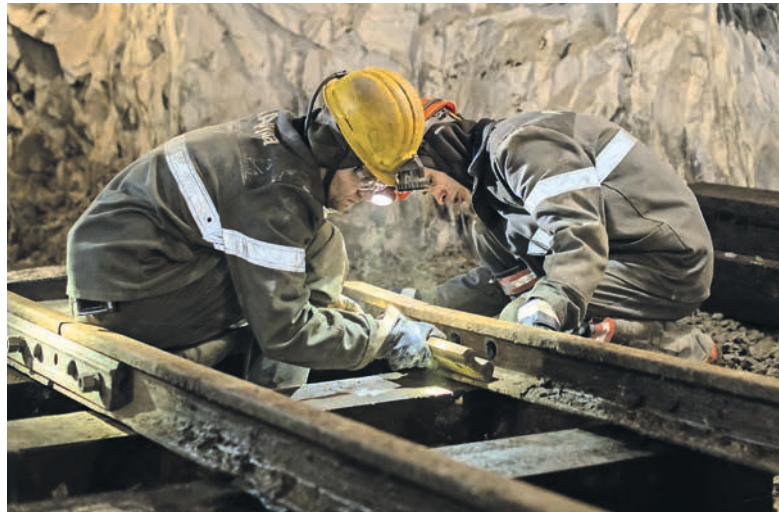
Установка стыковых накладок.
