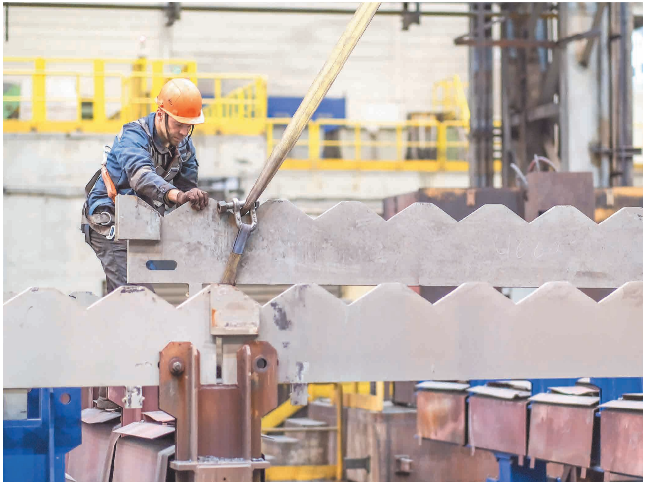
↑ Работы по замене частей шагающего кантующего холодильника МНЛЗ.
