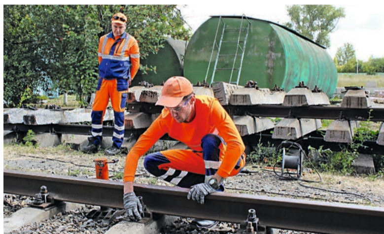
После замены железной подкладки необходимо тщательно затянуть все гайки.
