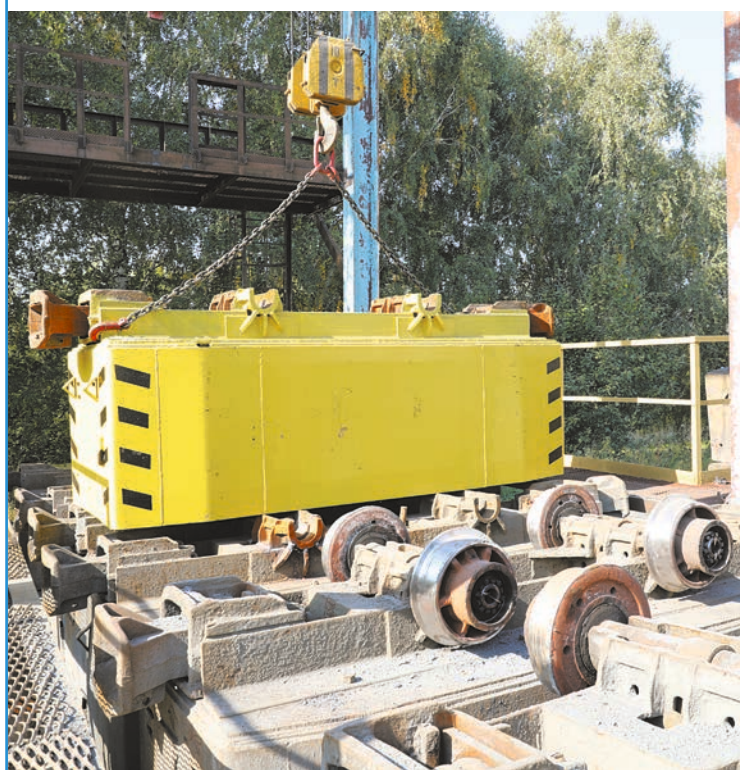
Монтаж нового корпуса вагонетки ВГ-4,5.
