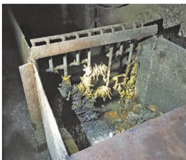
Внешний вид сороуловителя до модернизации.
