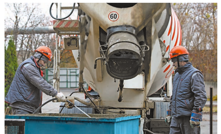
Бесперебойная подача раствора для стяжки пола первого этажа.
