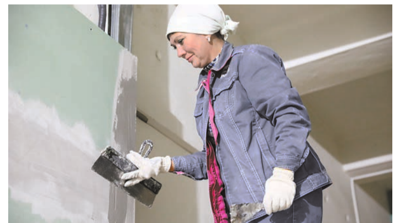
Финальные штрихи отделки стен под декоративную штукатурку.
