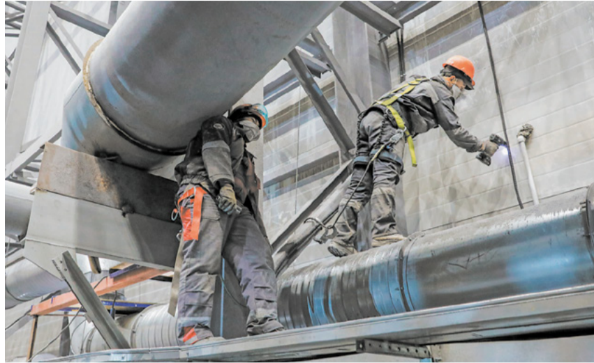
Систему аспирации на фабрике монтируют своими силами.
