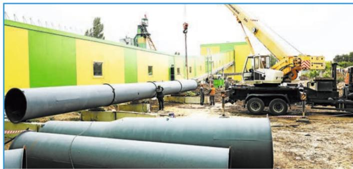
Протяженность системы аспирации корпуса средне-мелкого дробления – около 500 метров. Снаружи конструкцию монтируют работники РСЦ. Тру-
