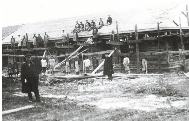
1930-е годы. Строительная площадка разведочной экспедиции КМА
