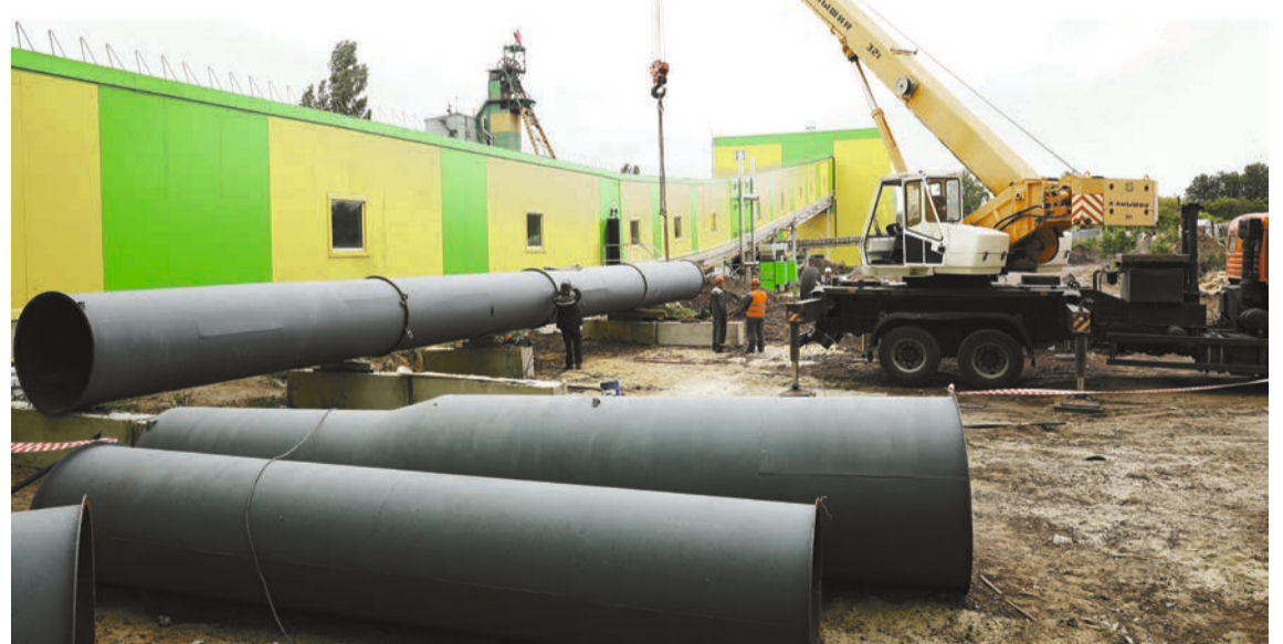
Бригада ремонтно-строительного цеха монтирует первые 20 из 34 запланированных метров вертикальной трубы диаметром 1250 мм
