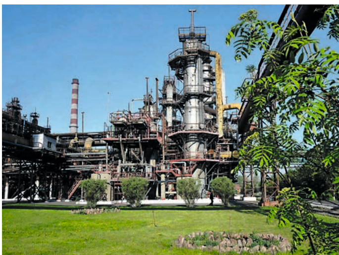
ПАО «Кокс». Установка КФС цеха улавливания химических продуктов коксования.
